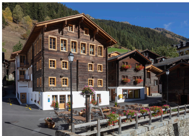
Fassaden Süd / West
